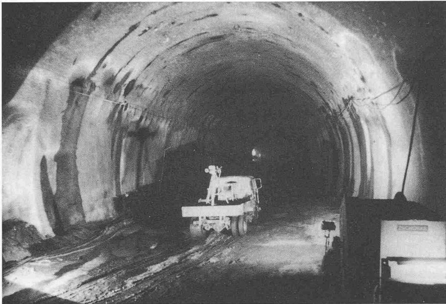
Bild 8. Profilmessgerät in Messposition, im Tunnel installiert auf einem Lastwagen
