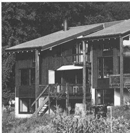
Überbauung Buchenweg. Detailsicht Südwesten
