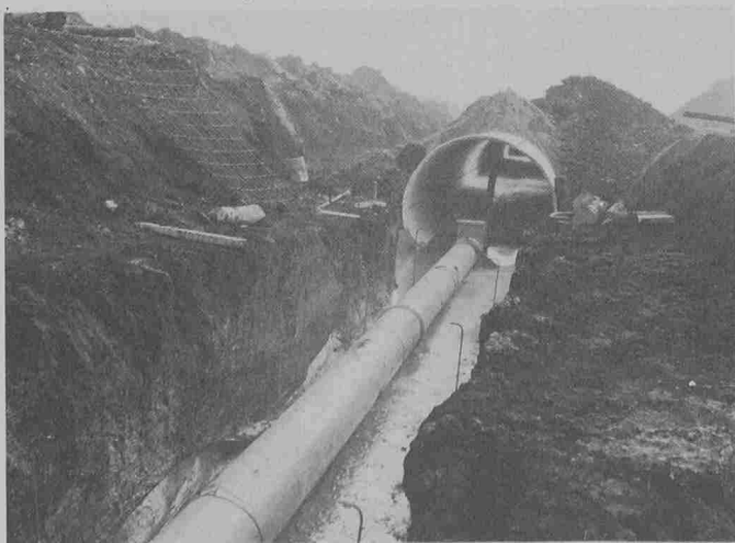
Einbetonierte PVC-Leitung in Armco-Rohr
