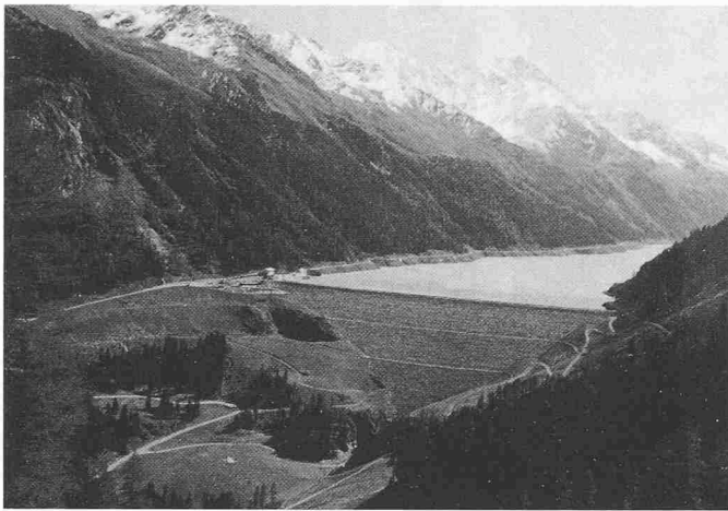
Bild 2. Die Talsperre als Kontrast zu ihrer Umgebung: Staudamm Gepatsch in Österreich (Werkphoto TIWAG, Innsbruck)
