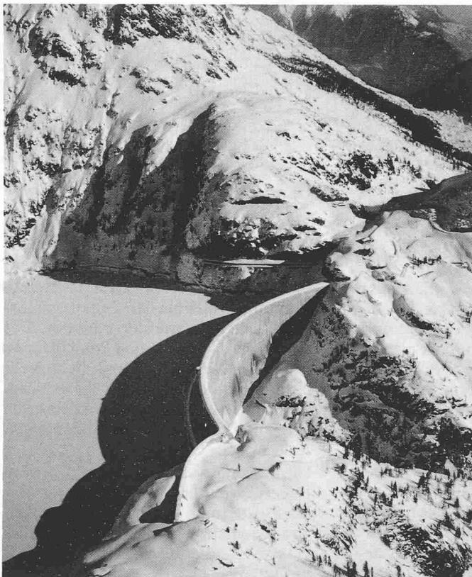
Bild 9. Die zwei kongruenten Ellipsen der Staumauer Emosson (Wallis) als ästhetischer Gewinn gegenüber dem Vorentwurf von Bogen und Polygon (Electricité d'Emosson S.A.)
