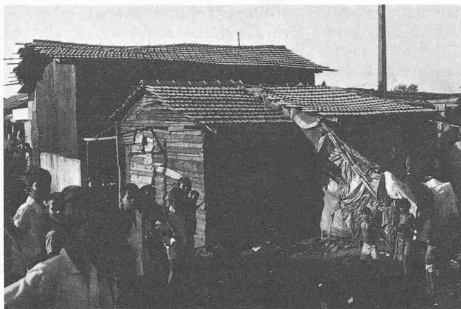
Bild 5. Slum-Upgrading (Foto Dr. G. L. Zander)
