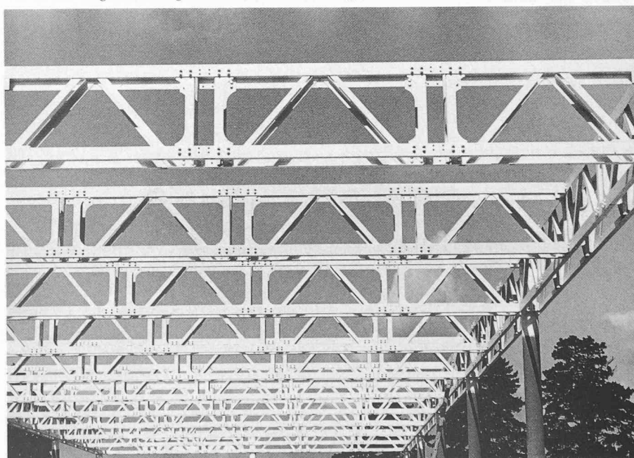
Bild 3. Die Träger des Schulgebäudes während der Montage
