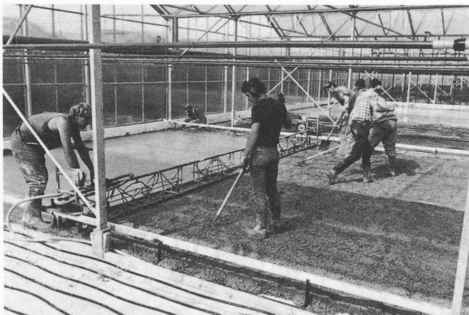
Bild 10. Betonieren von Betonböden mit Erderwärmungs- und Bewässerungssystemen für Gewächshäuser
