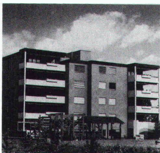
Foto: Peter Weber, BBI Bauberatung und Bauinformation
