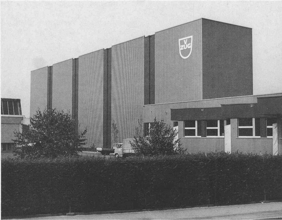
Bild 4. Hochregallager der Verzinkerei Zug
