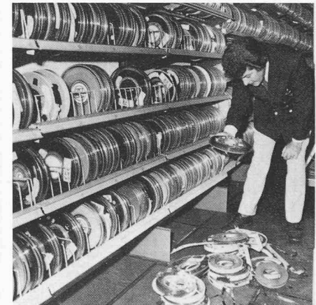
Was sind Brandmelder wirklich wert? Hunderttausende von Fr. wären hier ein Raub der Flammen geworden. Dank Frühalarm konnte der Brand in Schach gehalten werden
