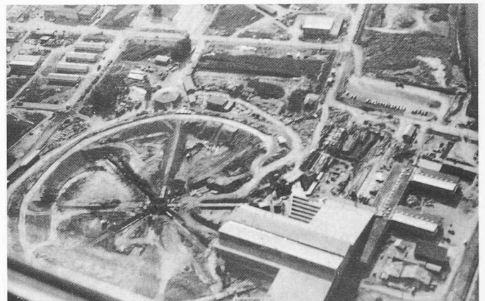
Luftaufnahme der Baustelle CERN in Genf (1954-57)
