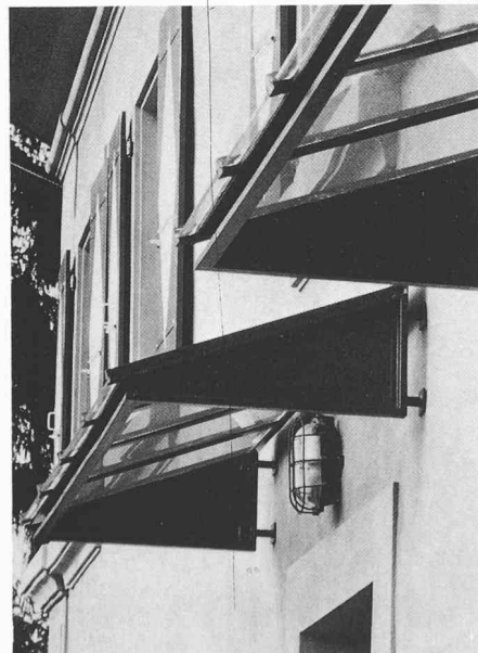
Les marquises des portes d'accès au jardin
