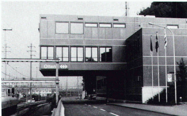
Neues Stellwerk Bahnhof SBB, Olten, Fahrbahnisoliation
