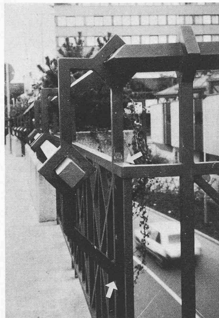
Bild 13. Elemente aus Gusseisen mit Kugelgraphit an einem Gelände beim Bahnhof Lörrach. Die von Vierkantrohren durchdrungenen Gusselemente sind mit den Pfosten verschweisst. (Werkfoto Giesserei Trikes, Lörrach)
