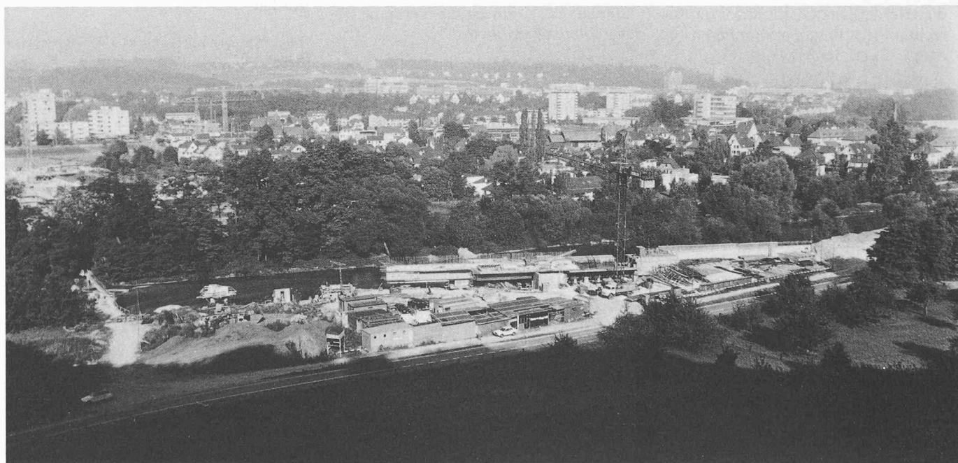
Bild 2. Produktionsstelle für Taktvorschub. Schnabelbereich und erste Etappe bereits eingeschoben
