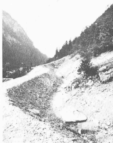
Bild 9. Östlicher und mittlerer Teil des Auffanggrabens mit den Sturzblöcken
