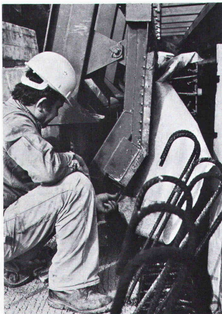
Bild 5: Die Vliesmatte wird unten im Schalwagen mittels Klemmschiene befestigt.
