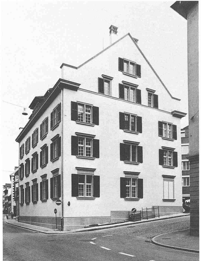
Der renovierte «Sonnenhof» an der Stadelhoferstrasse
