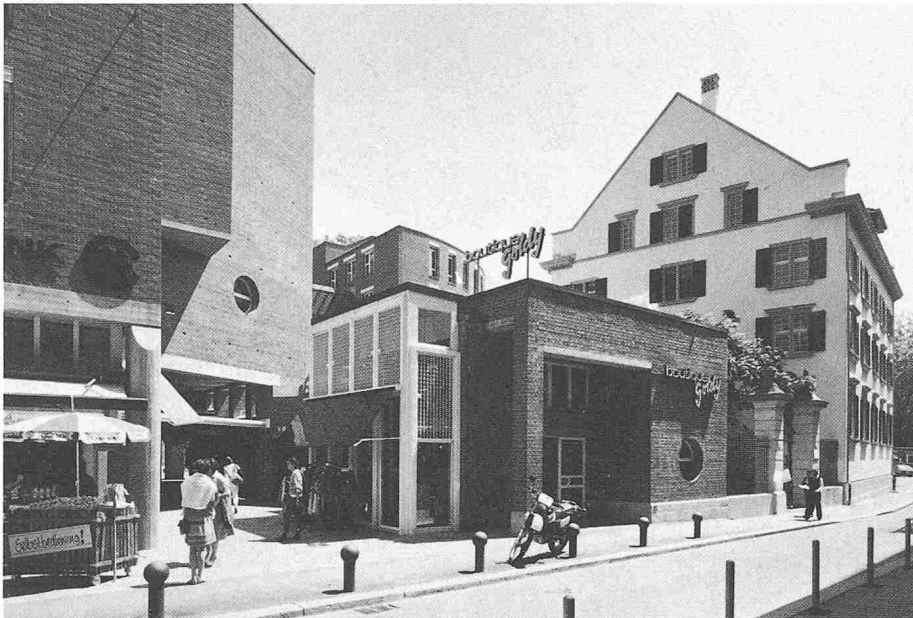
«Stadelhoferpassage», rechts der Sonnenhof, Neubauten von E. Gisel, Zürich (Fotos: G. Gisel)
