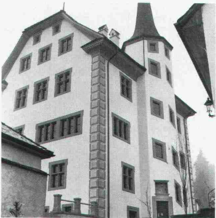
... wo historische Bauten gefährdet sind
