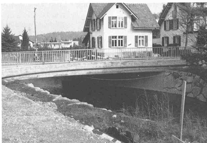
Bild 2. Neue Wynabrücke Vorstadt, Gränichen. Ansicht
