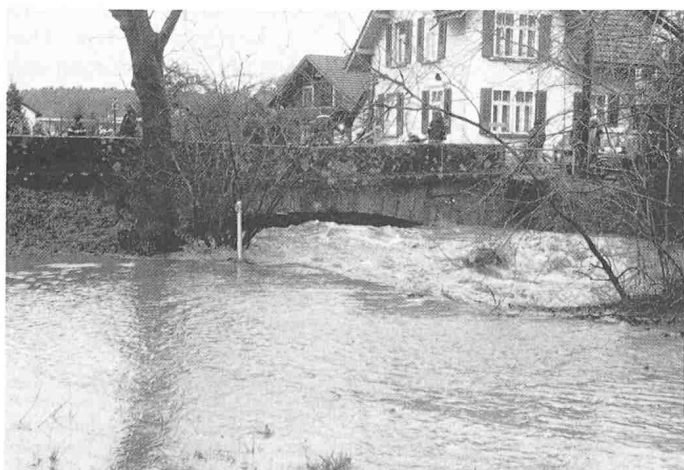
Bild 1. Alte Wynabrücke Vorstadt, Gränichen. Hochwasser
