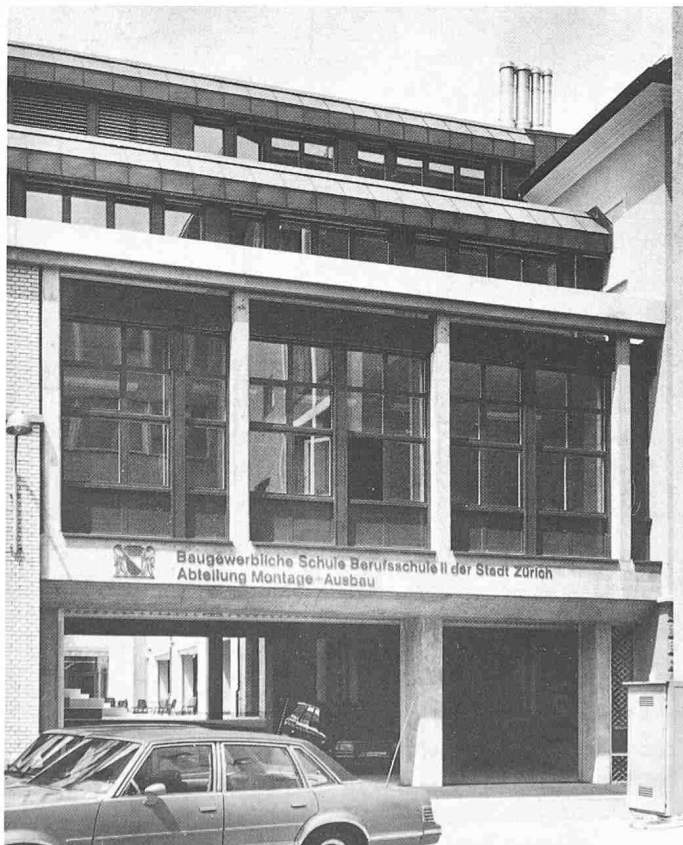
Reishauerstrasse. Hauptzugang zum Innenhof
