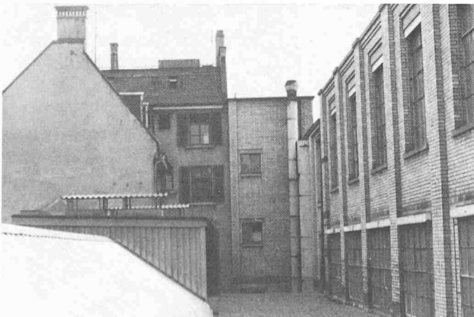
Reishauertrakt mit Blick gegen Wohnhaus Konradstrasse. Diese Fassade bleibt im Innern des Neubaus erhalten
