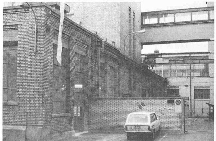
Reishauerstrasse. Blick in den Anlieferungshof, neu: unterer Innenhof
