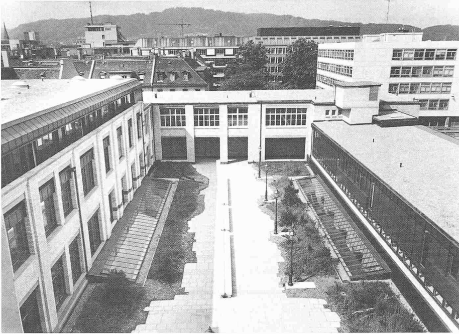
Oberer Innenhof. Pausenplatz auf dem Turnhallendach
