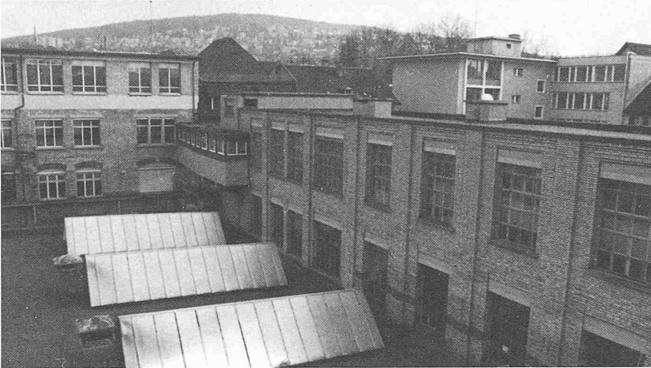
Früherer Innenhof. Rechts der Reishauertrakt mit Passerelle, Sheddach der abgebrochenen eingeschossigen Fabrikhalle, neu: Turnhalle
