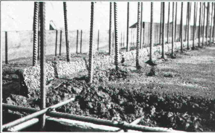
Erstellen einer Anschluss-Dichtung "BFL-MASTIX" Typ 20/70 R4.
