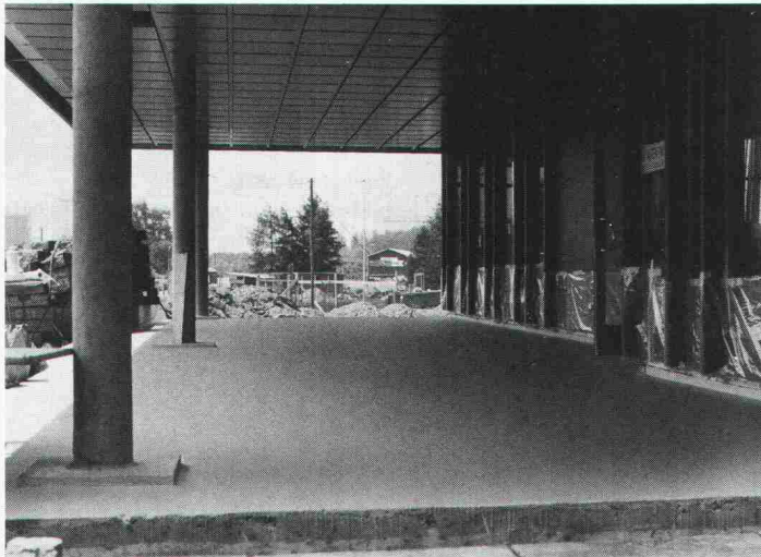
Eingangshalle Kläranlage Als wasserdichte Isolation unter Plattenbelag
