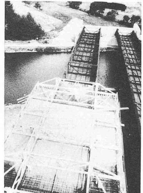
Bild 5. Schalgerüste im Einsatz
