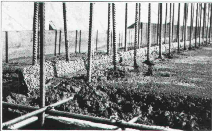
Erstellen einer Anschluss-Dichtung "BFL-MASTIX" Typ 20/70 R4.
