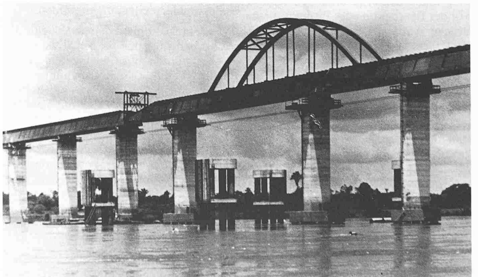
Bild 5. Bogenversteifter Hauptträger für die Schiffahrtsöffnung der Tocantins-Verbundbrücke während des Längsvorschubes
