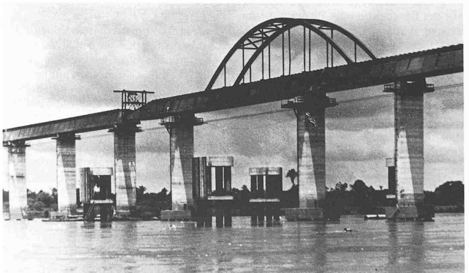
Bild 5. Bogenverstärkter Hauptträger für die Schiffahrtsöffnung der Tocantins-Verbundbrücke während des Längsvorschubes
