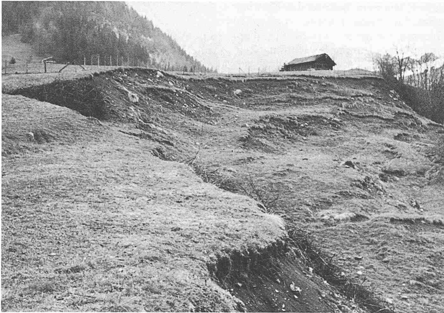
Bild 9. Rutschung La Frasse (Foto DUTI).
