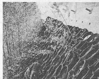
Bild 1. Begrünbare Böschungsbewehrung aus Altreifen Bild 2. Sanieren einer Hangrutschung
