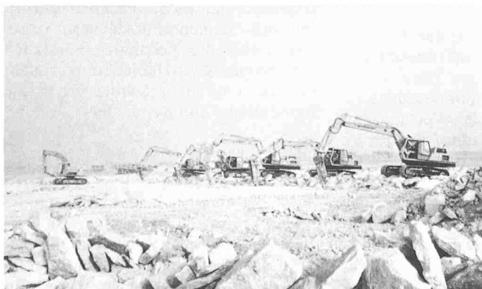
Bild 12. Grossflächen-Felsaushub mittels Hydraulikhämmern
