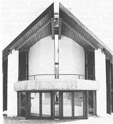
4210 Ipsach 1971-73 Seewasserwerk, baulicher Teil, Ing. Dr. Mathys & Partner
