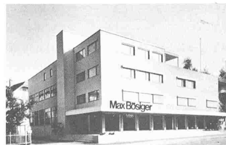
9114 Langenthal 1914–16 Haus Mittestrasse 13–15, Arch. Bösigger Walter
