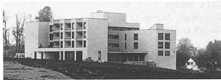
2410 Münchenbuchsee 1978–79 Altersheim, Arch. Hebeisen und Vatter
