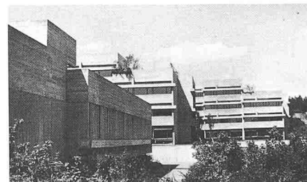
2422 Zollikofen 1962–66 Schulhausstrasse 30, Arch. Mäder und Brüggemann
