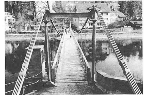
3006 Bern 5, Matte 1857 Altenbergsteg Kettenbrücke, Ing. Gränicher Gustav
