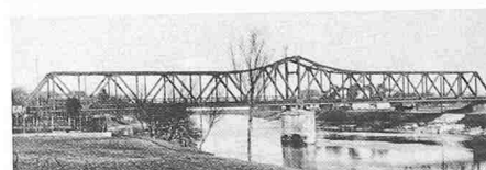
4311 Brügg 1928/1965 Eisenbahnbrücke, 1928 Ing. Wolf & Co., 1965 Losinger AG, Wartmann AG
