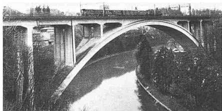
3091 Bern 5, Lorraine 1937-41 Eisenbahnbrücke, Ing. Bühler Adolf
