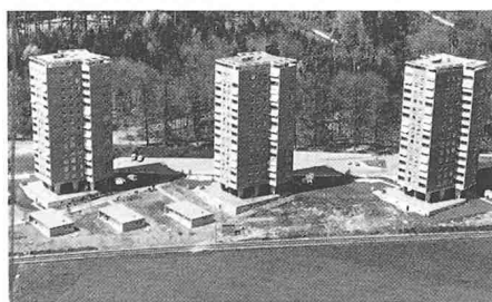
3140 Bern 3, Fischermätteli 1960-62 3 Hochhäuser, Holligenstrasse, Arch. Althaus Willy
