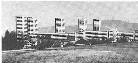
3123 Bern Stadt 1958-66 Tscharnergut-Siedlung, Waldmann-, Fellerstrasse, Arch.gem. Lienhard und Strasser, Reinhard H. und G., Helfer E., Kormann W., Indermühle P., Wettbewerb
