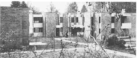
2304 Muri b. Bern 1976-80 EFH-Parksiedlung Vilette, in verdichteter Bauweise, Arch.gem. Hostettler Hans, Stukky Ulrich
