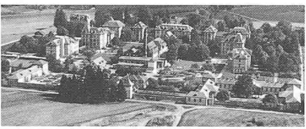
2070 Münsingen 1892-95 Heil- und Pflegenstalt, Arch.gem. Tièche A., Schneider Fr., Lutstorf O.
