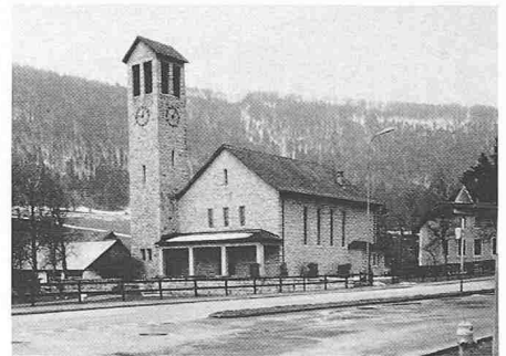
5210 Villeret 1961 Chapelle catholique, Arch. Bueche Jeanne
