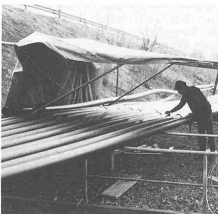
Bild 3. Verschweissen der Rohrstücke mittels Elektroschweissmuffen in Melide
