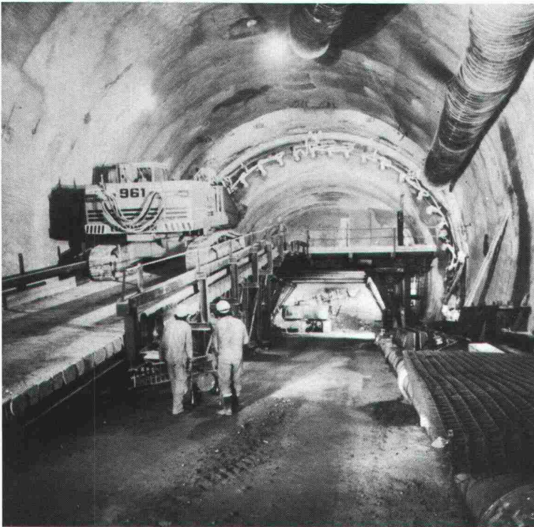
Anwendung des Gefrierverfahrens in der Moränestrecke
