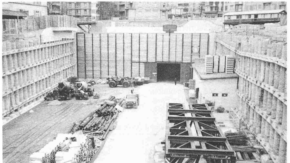
Bild 1. Lärmschutzdach im Voreinschnitt Süd mit schalldichtem Tor, das nachts geschlossen blieb
