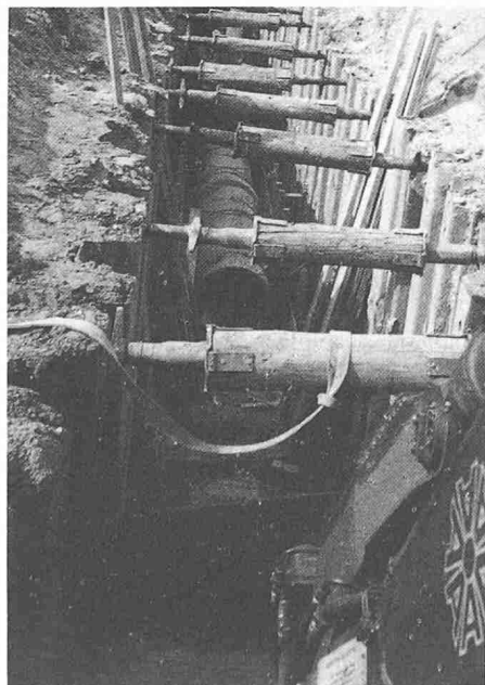
Rohrverlegung auf vorbereiteter Betonsole im gespundeten Graben auf der Höhe des Grundwasserspiegels
