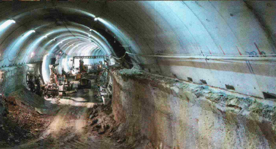
Kalottenvortrieb in der Molasse
