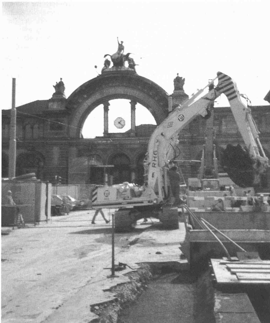
Bild 1. Aushubarbeiten für Untergeschoss bei Deckelbauweise
