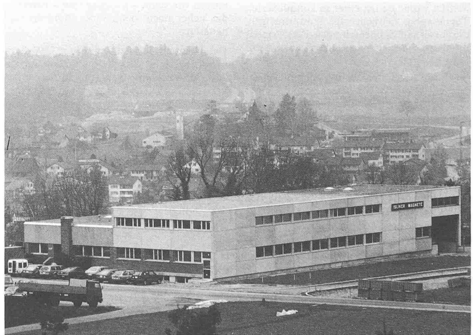
Bild 1. Erweiterungsbau der Isliker-Magnete AG, Andelfingen
