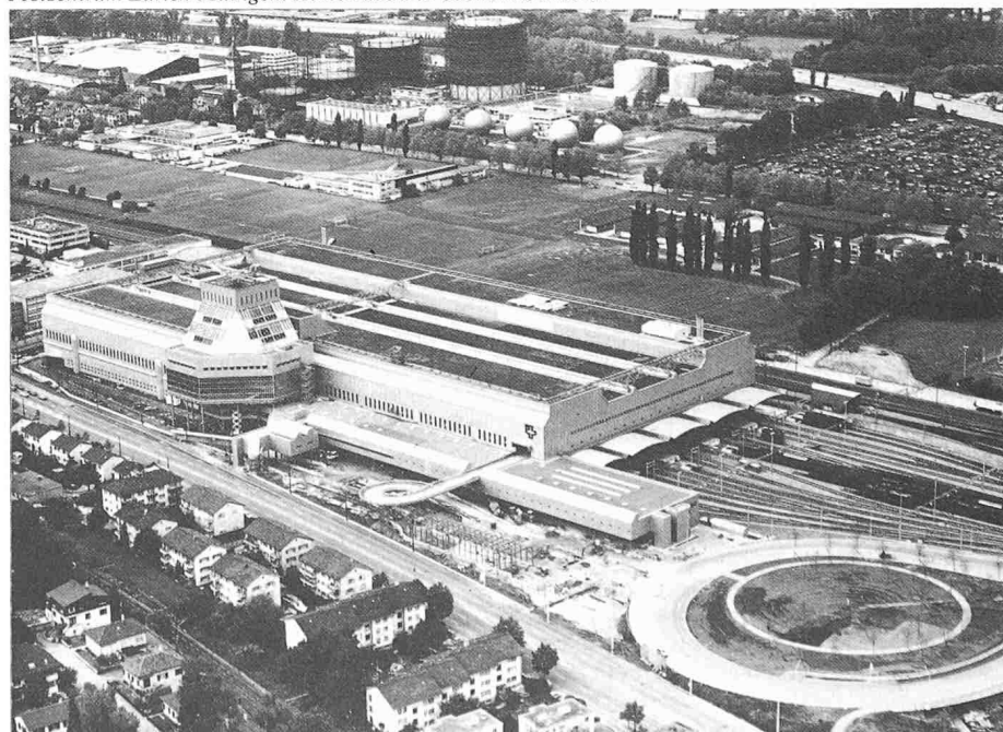
Postzentrum Zürich-Mülligen. Hinten das alte Gaswerk Schlieren
