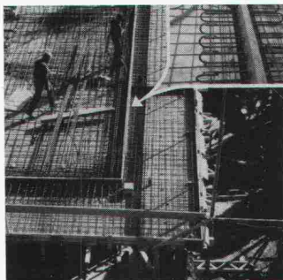
EGCO - wärmedämmender Kragplattenanschluss, stützenfrei
