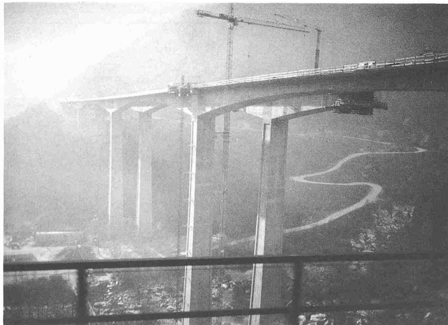
Bild 2. Autobahnviadukt in der Biaschina
