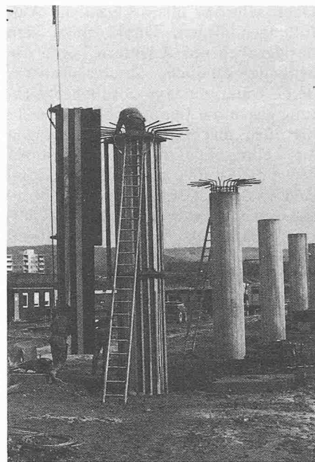
Bild 6. Stützen vorne: mit dem Überbau monolithisch verbunden hinten: zur Aufnahme der Punktkipplager
