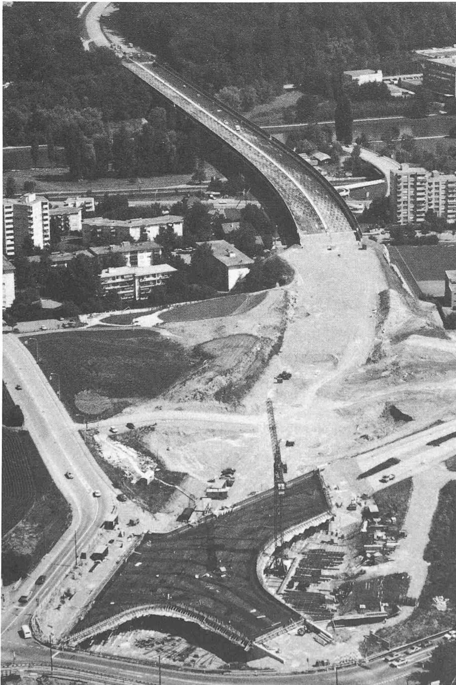
Bild 1. Übersicht. Unten das Bauwerk Überführung Bernstrasse, im oberen Bildteil das Anschlussbauwerk Limmattüberquerung (SIA 1981, Heft 8, Seite 166). Foto Swissair
