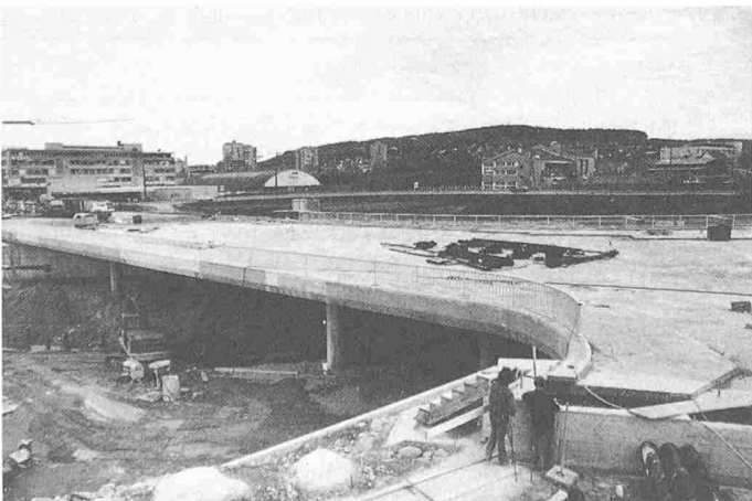
Bild 16. Die fertige Brücke von oben
