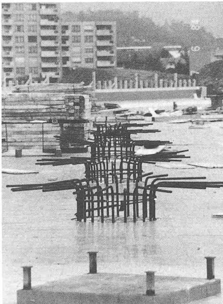
Bild 15. Kopfplatte zur Vergrößerung des Durchstanzkegels
