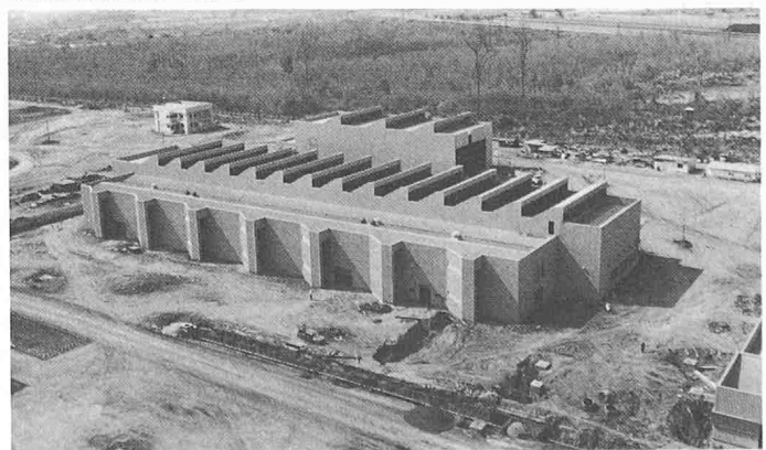
Bild 6. Werkstattgebäude. Sheddächer für minimale Sonneneinstrahlung. Hinten Braunkohlenmine
