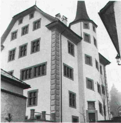
... wo historische Bauten gefährdet sind
