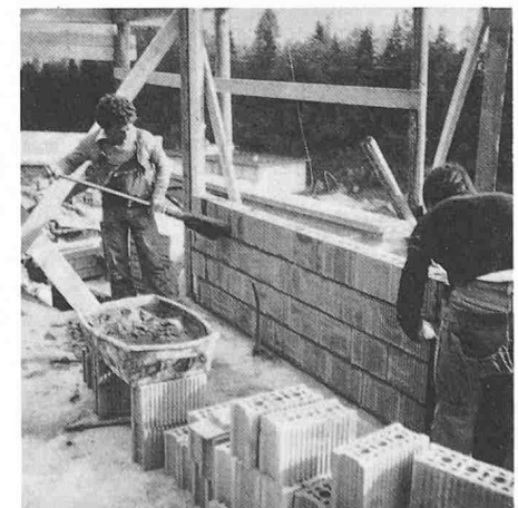
Bild 6. Abwischen des überstehenden Mörtels an der Aussenschale vor Versetzen der Wärmedämmung
