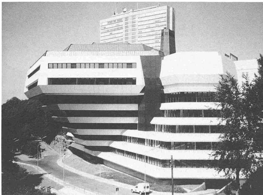
Bild 1. Europa-Kongresszentrum in Stahlkonstruktion
