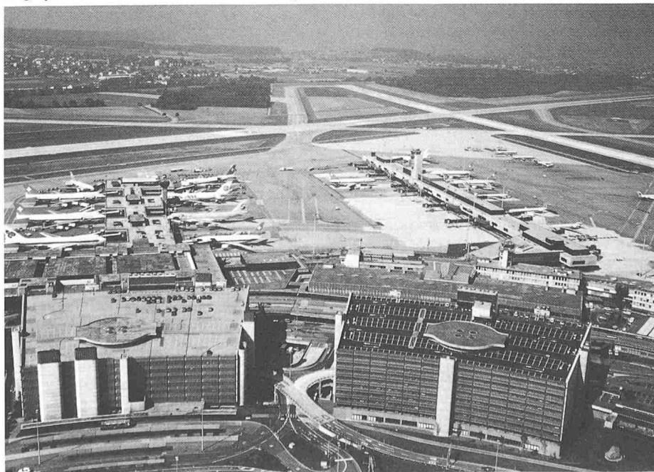
Flughafen Zürich. Übersicht mit dem neuen Fingerdock A
