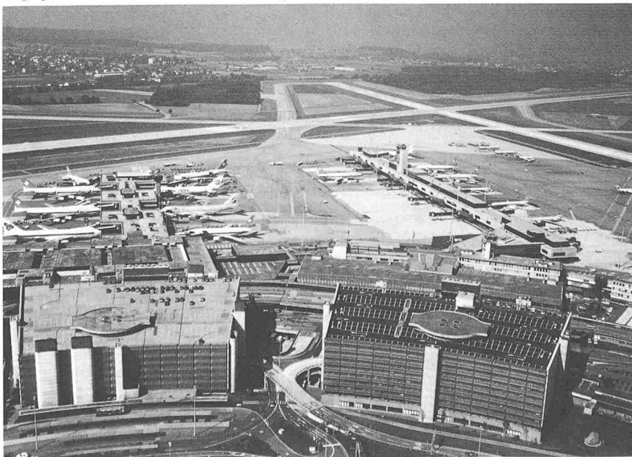
Flughafen Zürich. Übersicht mit dem neuen Fingerdock A
