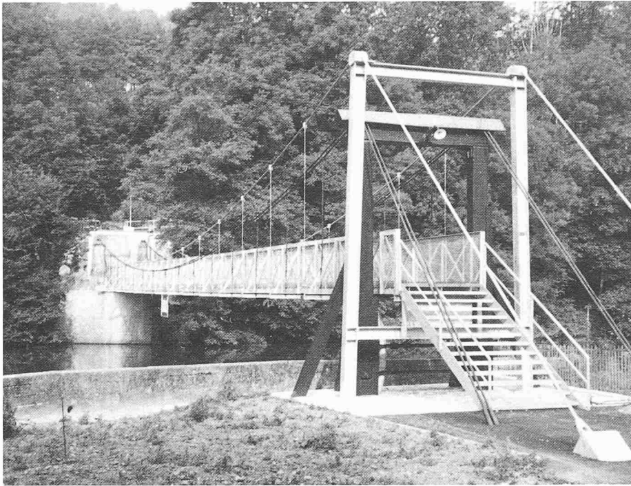
Bild 2. Sanierter Hängesteg. Die alten, erhaltenen Bauelemente sind in dunkler, die neuen in heller Farbe gehalten
