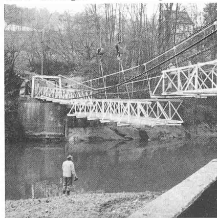
Bild 4. Einhängen zwischen den Trageisen
