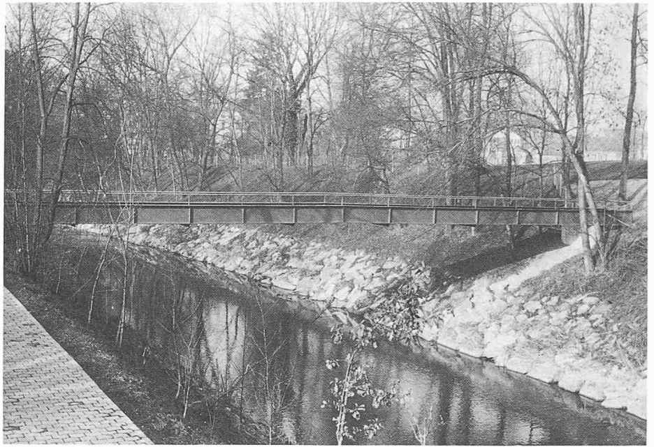
Bild 4. Fussgängerbrücke im Schwimmbad Frauenfeld, «Badisteg»
