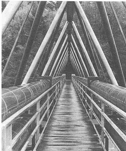
Bild 3. Durchblick mit Rohrleitungen
