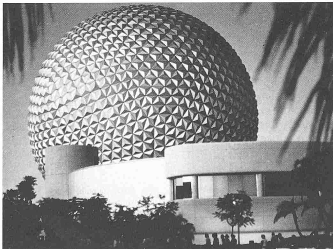
Bild 3. «Space Ship Earth». 18 000 m 2 anodisiertes Alucobond für das Wahrzeichen des «Epcot Centre» Orlando, Florida
